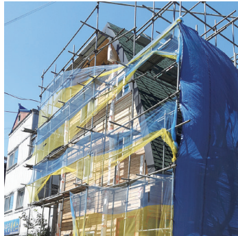
▲ 안전을 위하여 기울어진 도서관을 바로 세우는 공사 과정의 모습
