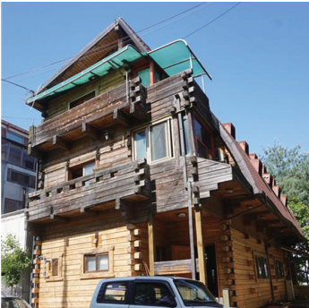
▲ 공사 전 외관
