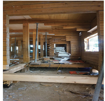
▲ 안전을 위하여 기울어진 도서관을 바로 세우는 공사 과정의 모습
