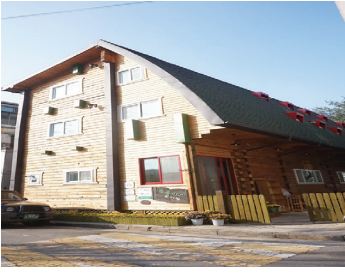
▲ 공사 후 외관
