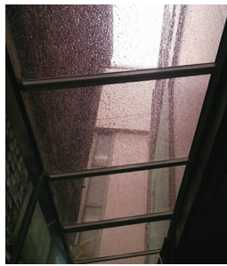
▲ 화장실 가는 길(전장공사 후)
