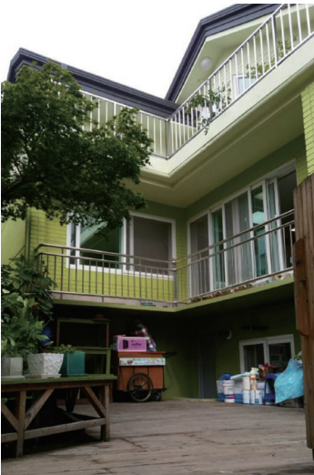
▲ 공사 후의 도서관 외관
