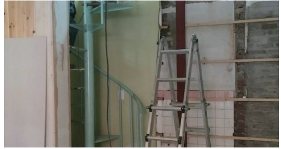
▲ 내부 공사 중의 모습
