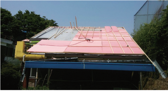
▲ 안전을 위한 지붕 공사
