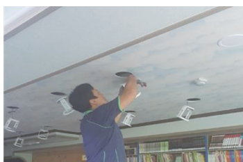
▲ 전기 공사 중
