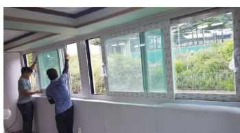
▲ 창호 공사 중
