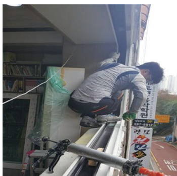
▲ 창호 공사 중
