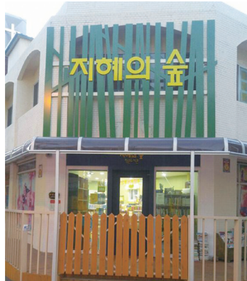
▲ 공사 후 ①
