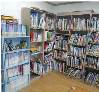
▲ 공사 전 서가 모습
