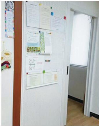
▲ 가벽과 출입문 설치
